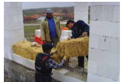
Şekil 6. (a) Anadolu'da Saman balyanın üretimi hızlanıyor. (b) Gazbeton ve saman balyalarla yapılmış bir özgün hibrit duvarı.
