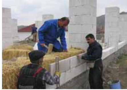
Şekil 13. (a) Kerkenes taş koruma-işleri binası. (b) Gazbeton kolonları ve dışardan gazbeton levhalarıyla korunmuş saman balya duvarı.
