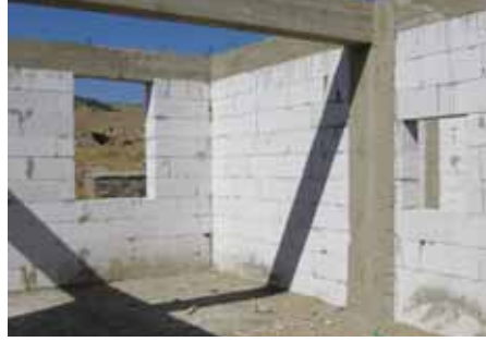
Şekil 12. (a) Erdoğan Akdağ Eğitim ve Araştırma Merkezi. (b) Betonarme strüktürü ve gazbeton bloklarıyla örülmüş duvarları.
