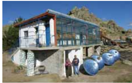
Şekil 9. Kerkenes Güneşevi binası ve güneşe bakan güneş balkonu.
