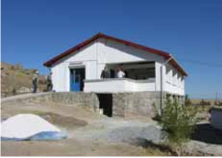
Şekil 13. (a) Kerkenes taş koruma-işleri binası. (b) Gazbeton kolonları ve dışardan gazbeton levhalarıyla korunmuş saman balya duvarı.
