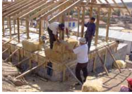
Şekil 11. (a) Saman balya binası. (b) Ahşap iskeleti ve saman balya duvarların yapımı.
